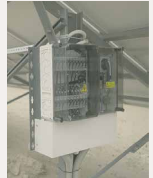
PV-Verteilerkästen in der Nähe einer Wüstenoase für ein netzunabhängiges Wasserpumpensystem.
