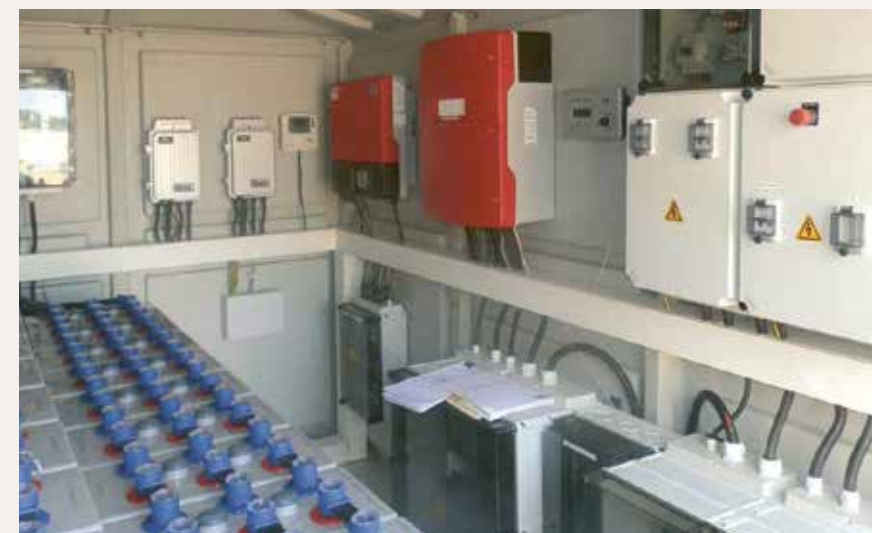
Elektrifizierung von Schienenwegen im Kongo mit Stromversorgung
